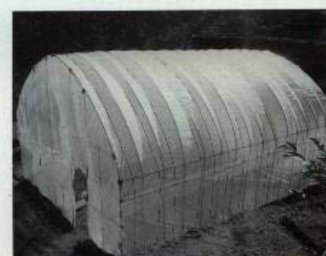
▲ネパールに農業用ビニールハウスはなく、鉄製水道管を骨組みとし、日本から持ちこんだ部品は規格があわず、苦労しましたが何とかできました。寒い時期にこの中で育苗することにより、今までより作季・作期の拡大が可能となり、その経済的効果は計り知れません。高面サツマイモ、キャベツ、カリフラワー、カボチャ、キュウリなどの育苗を考えています。
