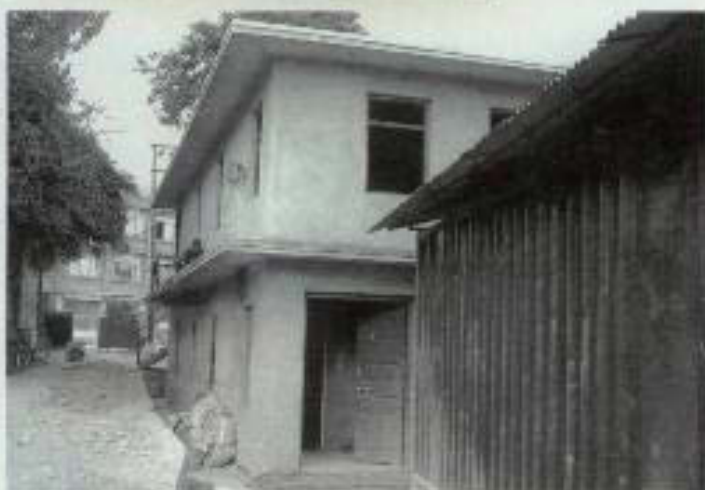
▶増改築が進むカトマンズ事務所。建物の中に入っていたコンテナ(右)を外に出し、2階部分を増築しました。
