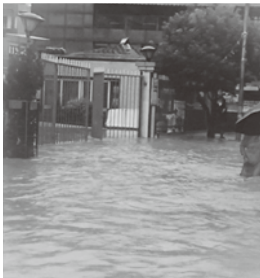
▲9月下旬、ネパールを襲った雨期末期の大雨によって排水機能が不全となり、大量の雨水がカトマンズの道路、建物を覆った。(ジャイチネパールからの発生時のメールより)
