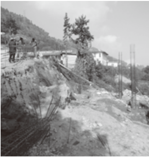
▲生徒数の増加に対応するために、新しい校舎の建設が始まったカカニ・ブライター学校。鉄骨2階建て1棟で、各階に4部屋ずつ計8部屋ができる予定。奥に見えるのは従来の校舎で、今回計画された校舎は校門の近くに設置される。
