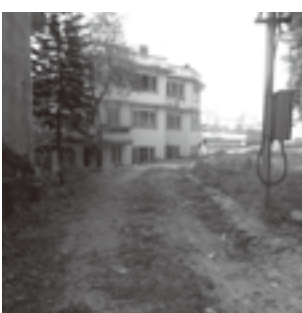
▶既に建物が取り壊され道路敷となつた旧事務所跡地
